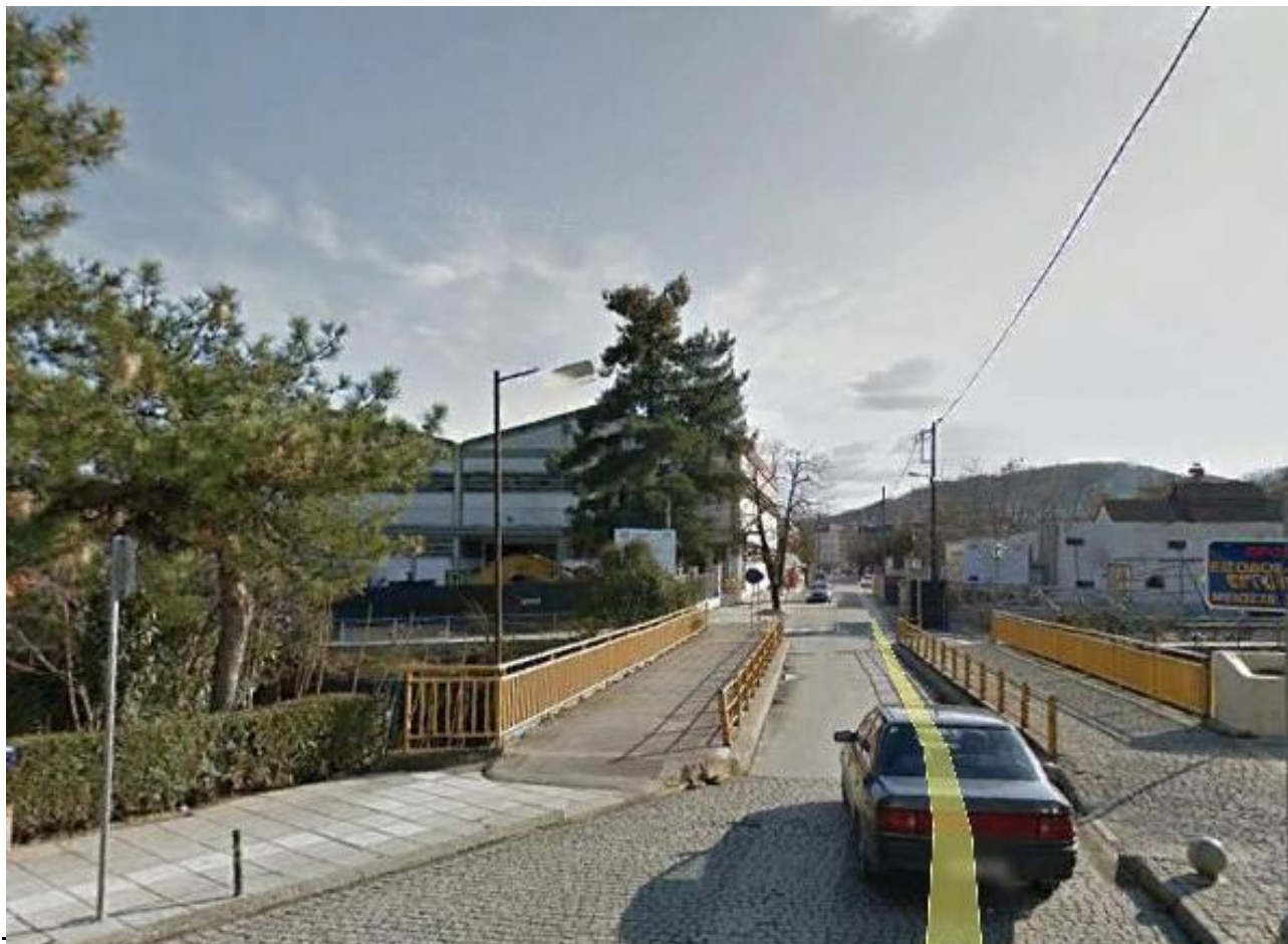
Εικ. 2: Βόρεια είσοδος υπάρχουσας γέφυρας
