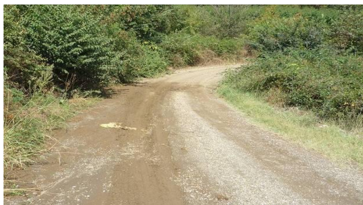
Φωτ. 2: Λήψη επί της υφιστάμενης Οδού περί τη Χ.Θ.1+400(km+m) σε θέση ρεματιάς, όπου εμφανίζεται η υποδομή του οδοστρώματος που χρήζει βελτίωσης.
