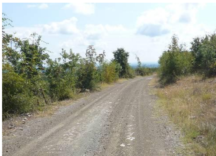
Φωτ. 3: Λήψη επί της υφιστάμενης Οδού περί τη Χ.Θ.1+700(km+m).
